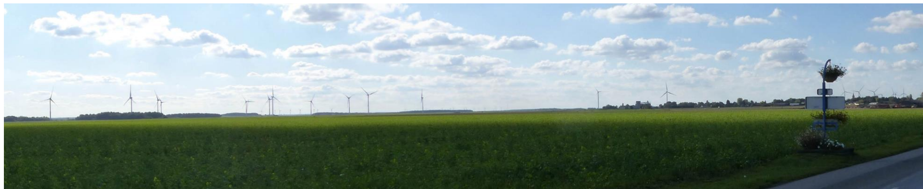
Point de vue sur le parc éolien de la Sablière, Champs Perdus et Santerre Energies à l'ouest d'Arvillers.
