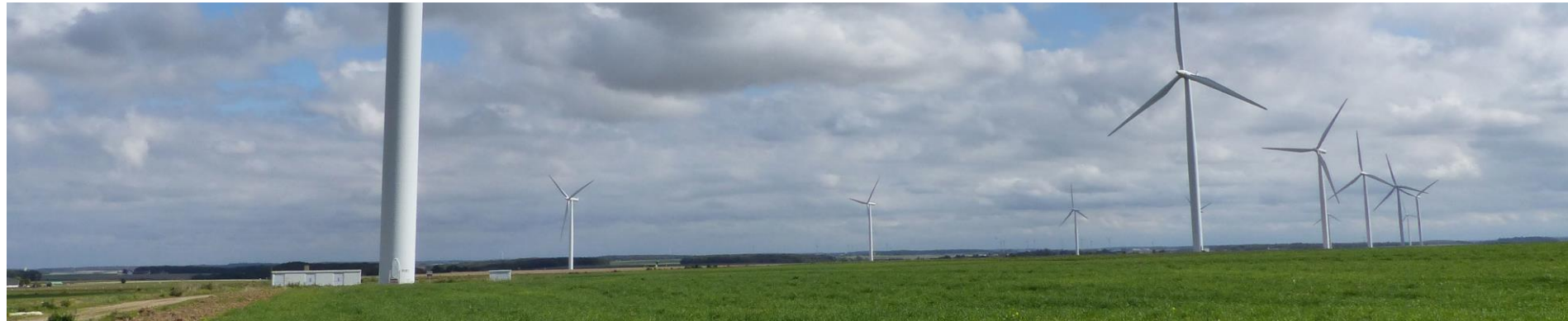
Point de vue sur le parc éolien Le Val de Noye I & II au sud de Louvrechy.
