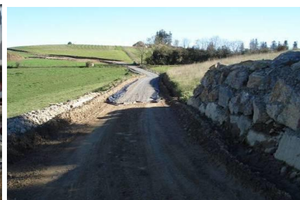
Mise en place du gravier
