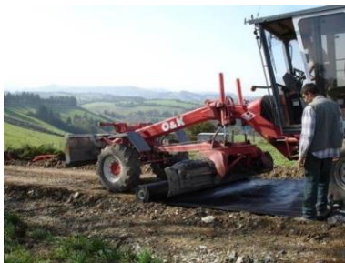
Pose du géotextile
